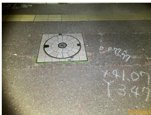
図 2-6 地表物オフセット計測
