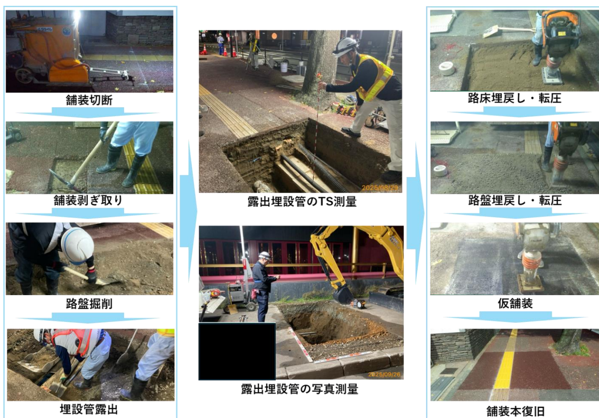
図 2-18 試掘調査手順の概要
