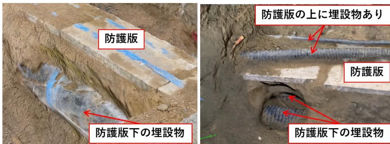
図 2-36 防護コンクリート版と埋設物の敷設状況（左：広島市、右：福岡市）
