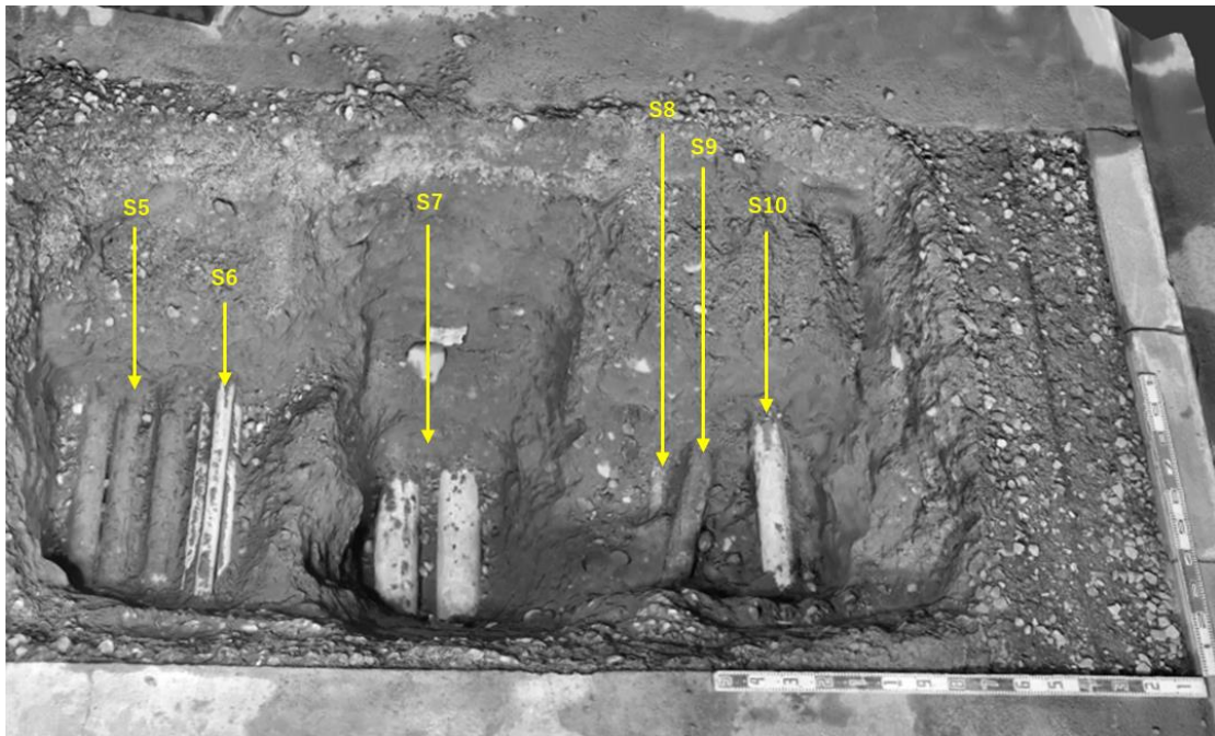
図 2-22 札幌市 試掘箇所 2 埋設管露出状況
