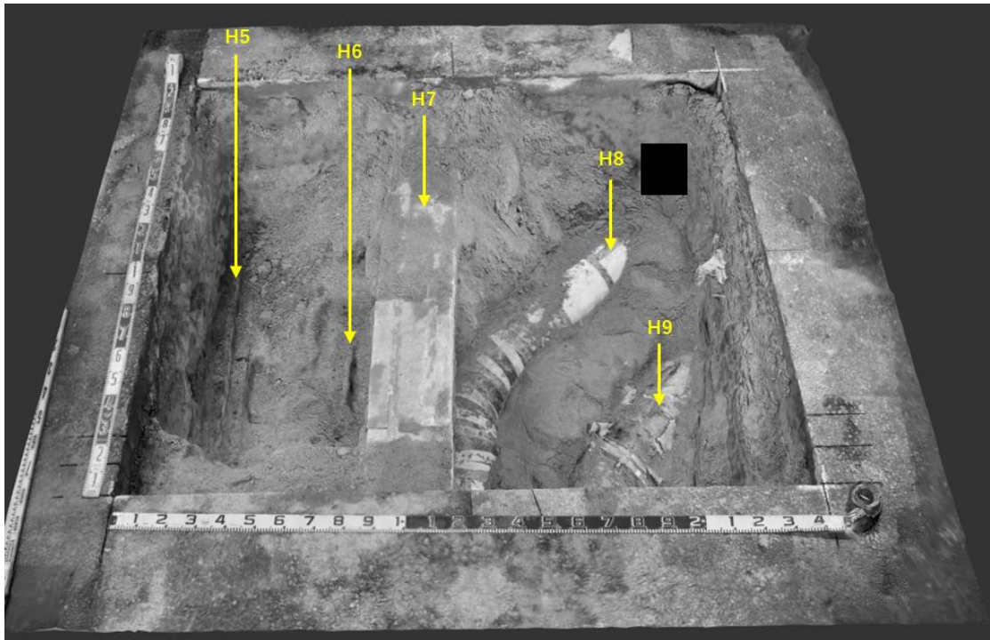
図 2-24 広島市 試掘箇所2 埋設管露出状況
