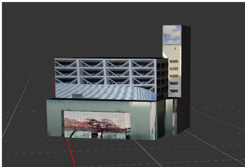
図 7-17 a-2 商業ビル（前橋）PLATEAU Builder で可視化
