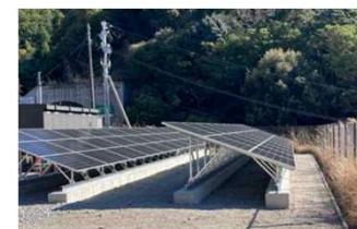
太陽光発電施設の設置
