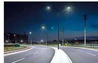
道路照明のLED化
