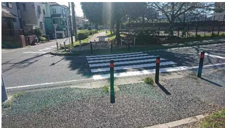
撤去後（通常の横断歩道）
