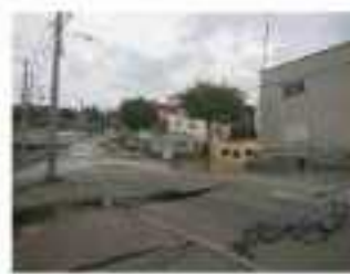
【宅地被害の状況】 (北海道札幌市清田区)
