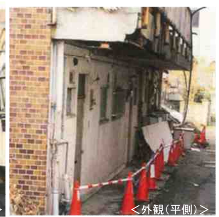
外壁、手すりが崩落した事例
