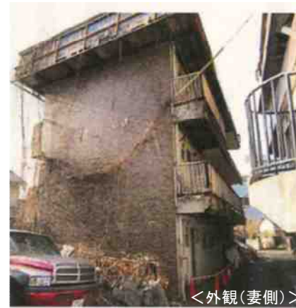
外壁、手すりが崩落した事例
