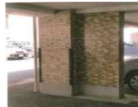
補強壁を設置
