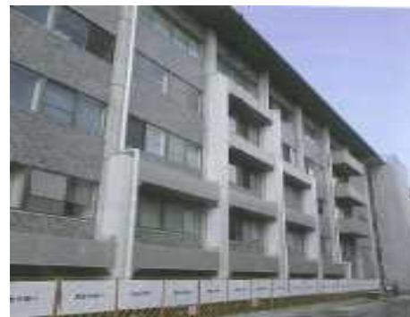
外付けフレームを設置
