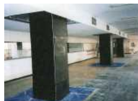
柱に炭素繊維シートの巻き付け
