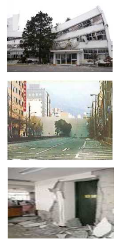
(※) 東日本大震災後のA市役所の損傷状況
