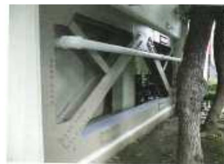
受水槽室の壁に筋かいを設置
