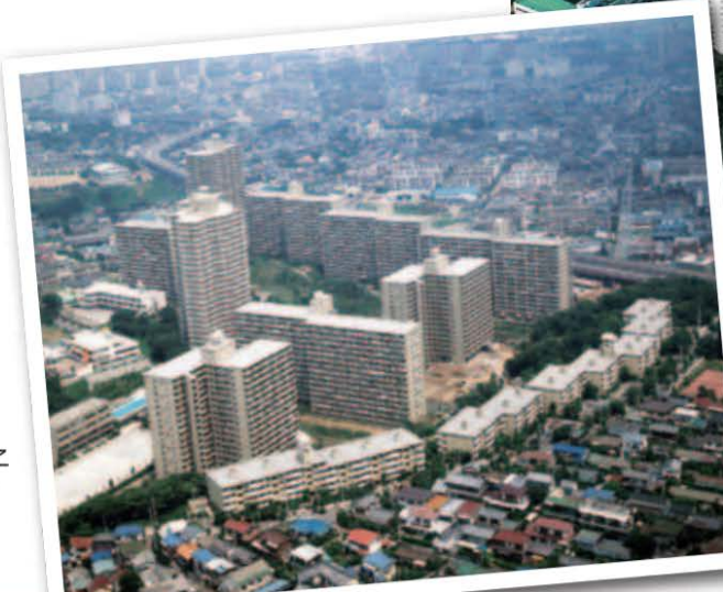
竣工当時の様子
