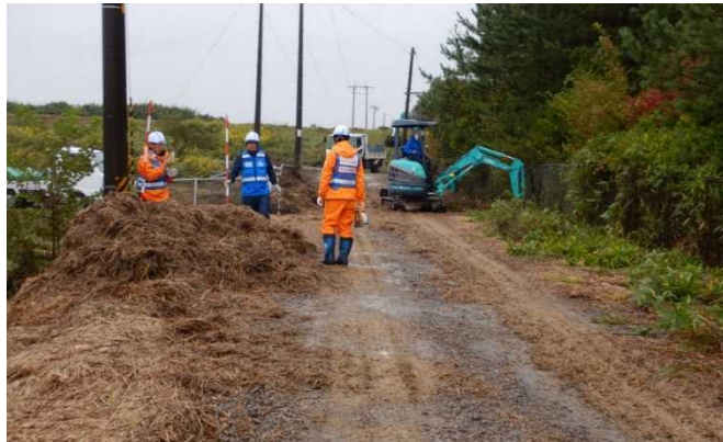
▲側溝清掃作業状況
