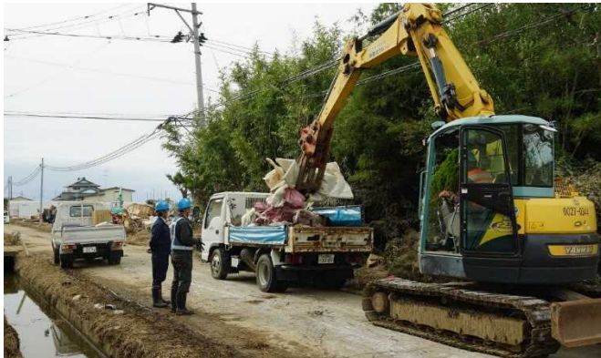
▲土砂(がれき)撤去作業状況
