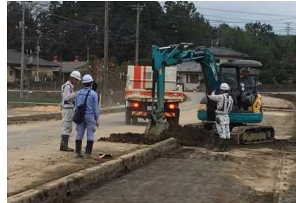
▲土砂(がれき)撤去作業状況
