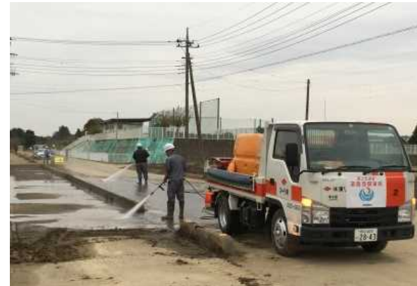
▲路面清掃作業状況
