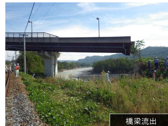
市道白鳥神社線の被災状況(海野宿橋)
