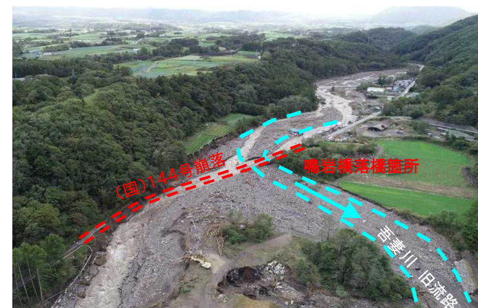
国道144号の被災状況
