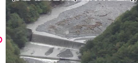
台風第19号 砂防堰堤が土砂・流木を捕捉(小瀬戸第1砂防堰堤(三峰川本川上流部))
