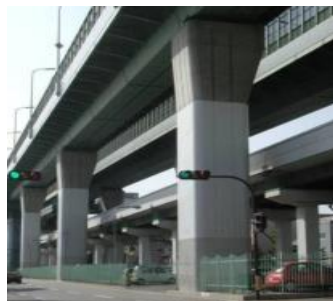
阪神高速道路の橋脚
