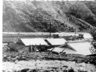
S36災 伊那市長谷の被災状況
