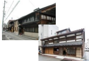
まちなかでの空き町家の修繕等への補助
