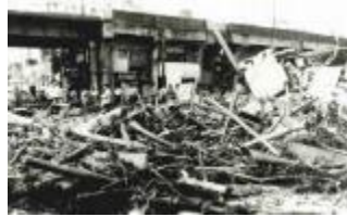
昭和42年災害の被災状況
