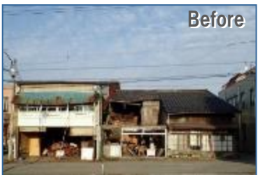
空き家の除却
