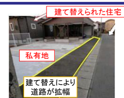
狭隘道路の解消となった例
