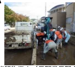
堆積物撤去（長野県長野市）
