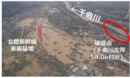
信濃川水系千曲川浸水状況（長野県長野市）
