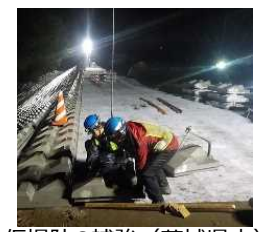
仮堤防の補強（茨城県内）
