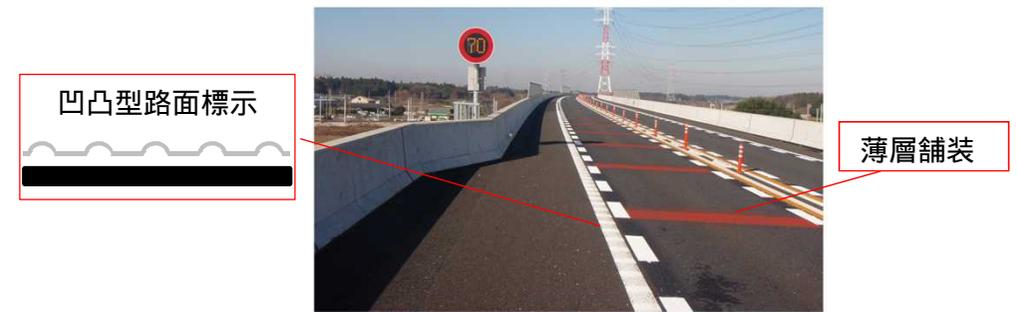
・トンネル進入速度抑制を目的とした路面標示
