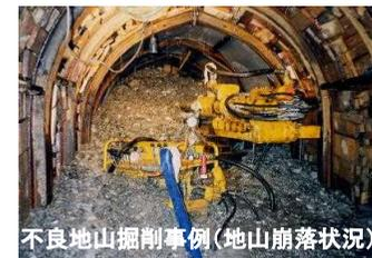
不良地山掘削事例(地山崩落状況)
