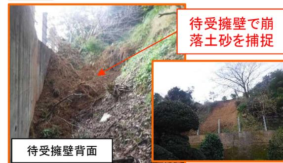
待受擁壁で崩落土砂を捕捉
