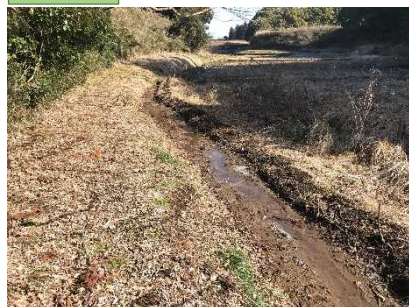
小動物の移動阻害のない素掘り水路
