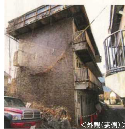
外壁、手すりが崩落した事例
