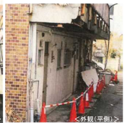
外壁、手すりが崩落した事例
