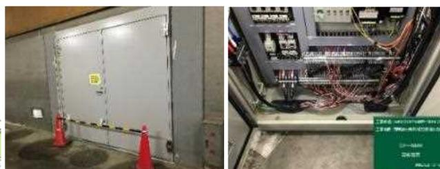
T1地下水密扉の設置・T1制御盤の嵩上げ等
