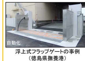
浮上式フラップゲートの事例(徳島県撫養港)
