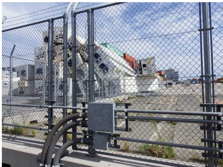
D4コンテナ倒壊
