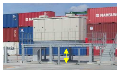
電気系設備の嵩上げ
