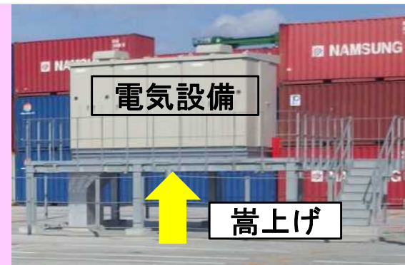
電気設備の嵩上げ事例
