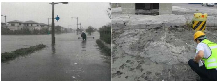
浸水被害の状況 (尼崎西宮芦屋港海岸)
