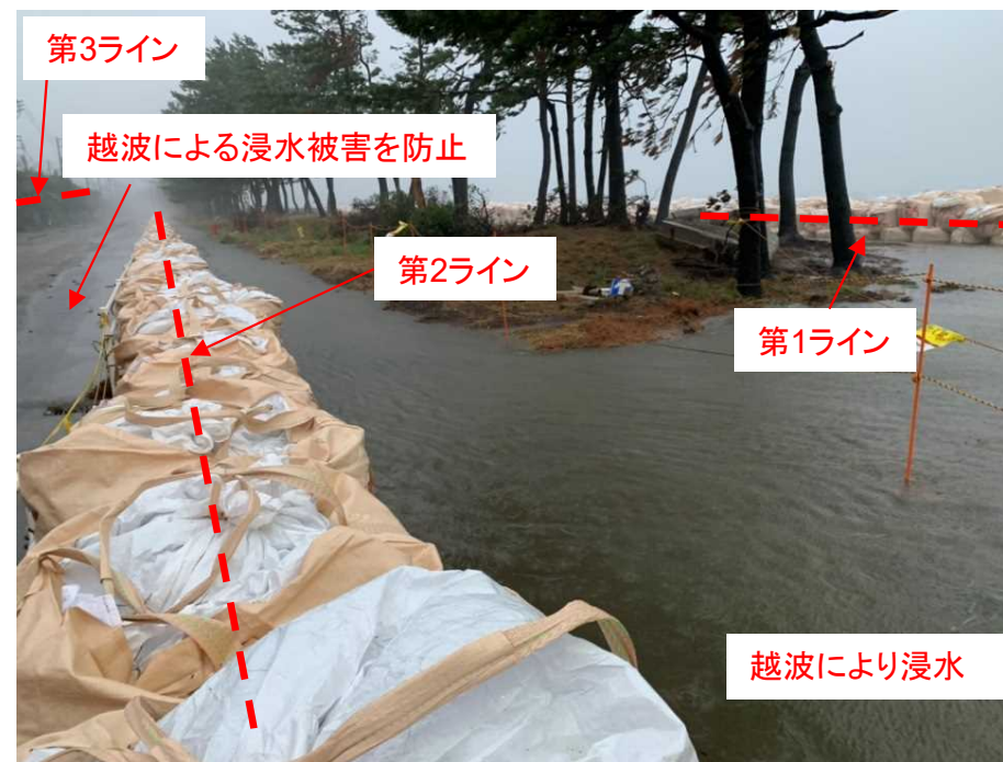
土のうを3列に配置し浸水被害を防止(10月12日撮影)
