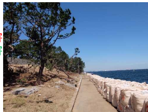
護岸応急復旧状況 (9月19日撮影)
