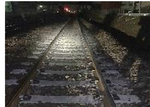
埋設物のない線路
