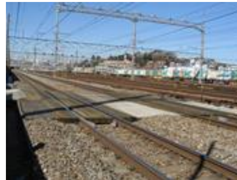
工事用重機械の搬入通路
