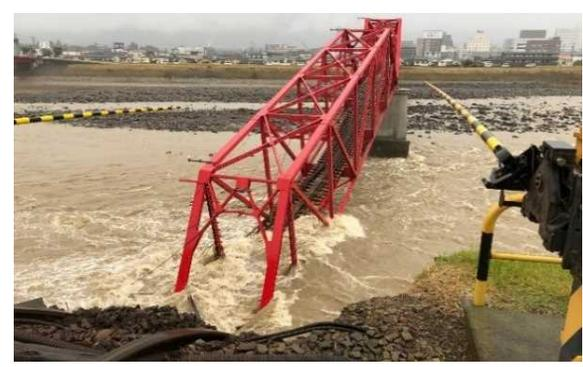
千曲川橋梁崩落状況（長野県上田市）
