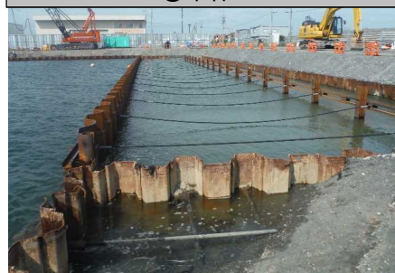
東港区物揚場(-3m) 本体工完成状況
