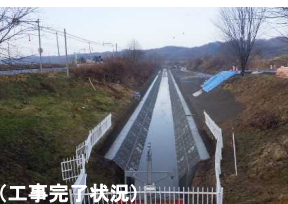
新鷲川地区 川西幹線用水路 (復旧状況)
