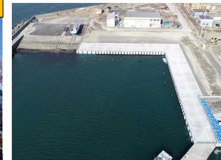
東港区物揚場(-3m) 復旧完了状況
