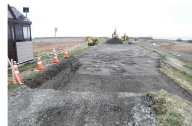
切り返し工が完了した箇所は順次、盛り土施工を開始。
