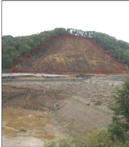
【新鷲川地区】川西幹線用水路 流入した土砂による開水路の閉塞
