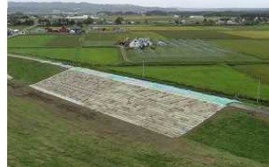
緊急復旧工事完了【9月13日】
