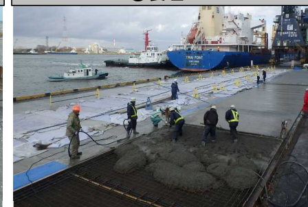
西港区中央南埠頭岸壁コンクリート舗装施工状況
