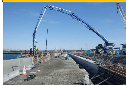
東港区物揚場(-4m) 上部コンクリート打設状況
