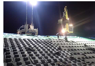
緊急復旧工事状況【9月10日】
