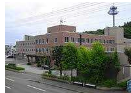
重要インフラの緊急点検(官庁施設)
