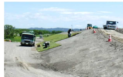
整形完了後、植生を実施。
