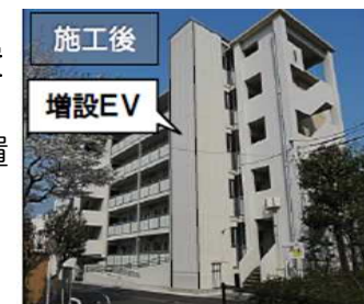
エレベーターの設置
