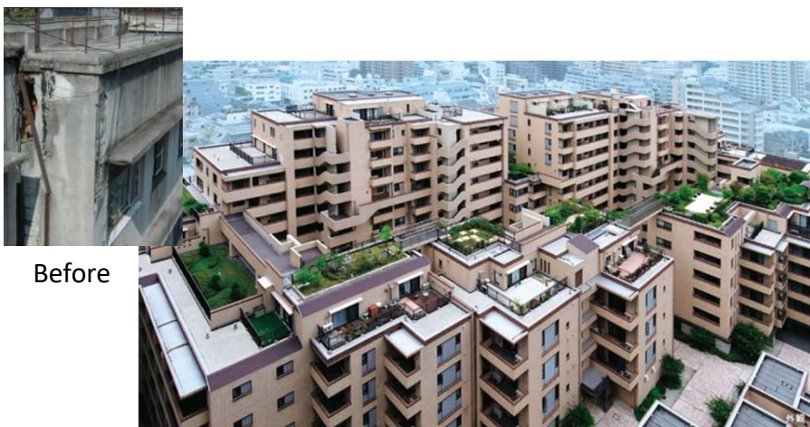
老朽団地建替(江戸川アパートメント)
