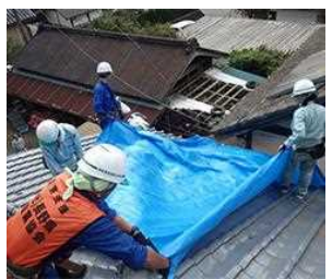
ブルーシートの設置状況（芝山町）
