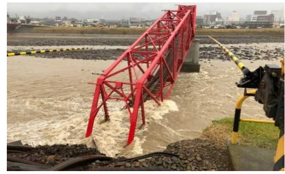
千曲川桥梁崩落状況（長野県上田市）
