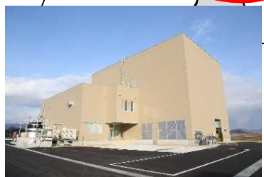
大館処理センター 汚泥資源化施設
