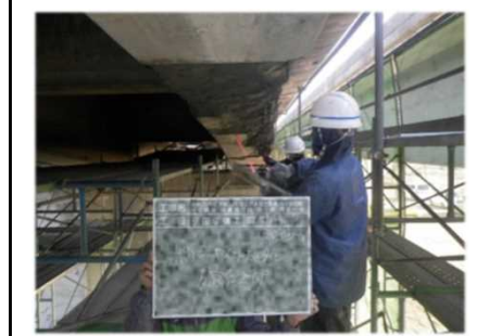
修繕の様子(断面修復)
