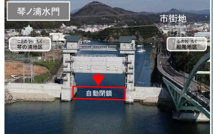
水門による津波・高潮対策
