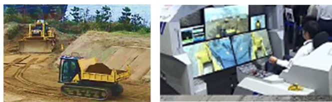
5G等を活用した無人化施工技術開発の加速化
