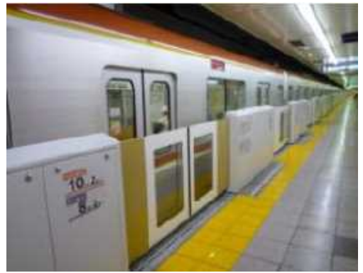
視覚障害者誘導用ブロックやホームドアの整備
