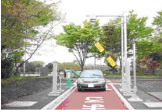
SA・PA等に接続し、地方公共団体が主体となって整備するETC専用のスマートインターチェンジ
