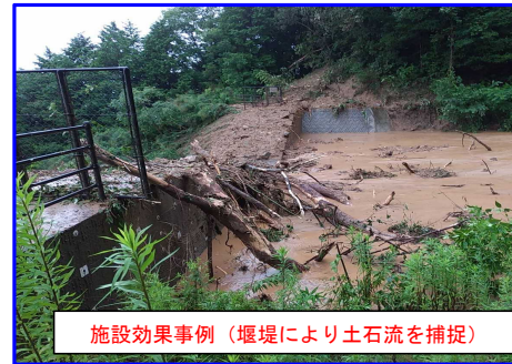
7/6 土石流等 ひろしま にしく いのくちだい 広島県広島市西区井口台3丁目
