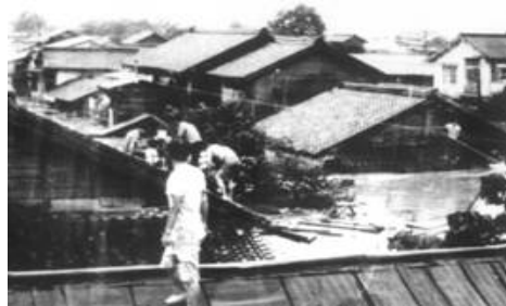
人吉市青井町の浸水状況
