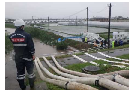
排水活動状況(福岡県久留米市)
