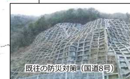
既往の防災対策（国道8号）
