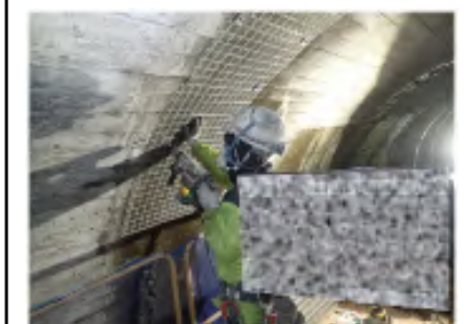
修繕の様子(剥落対策)
