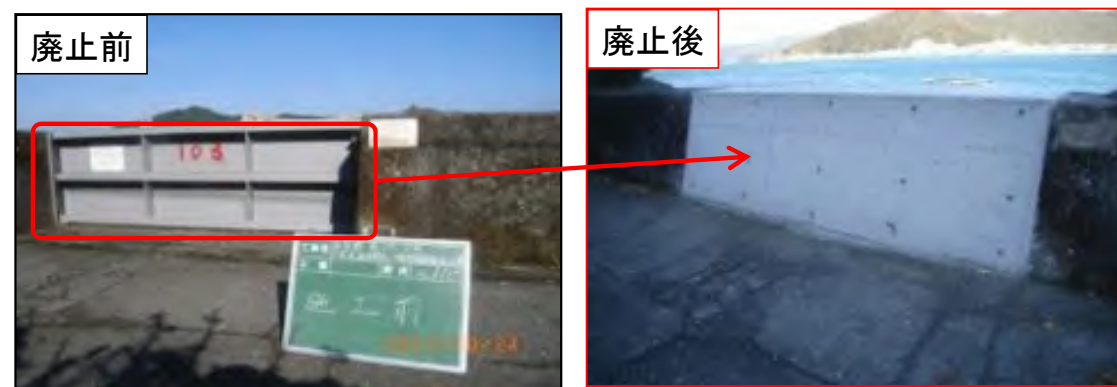
集約化等により利用度の低い陸閘を完全に廃止
