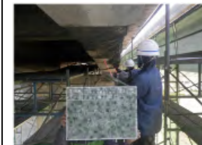
修繕の様子(断面修復)
