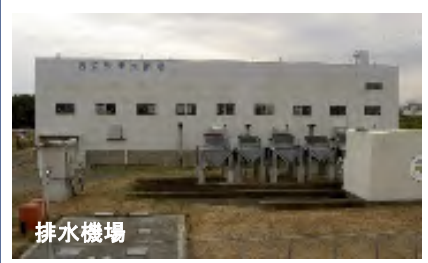
【排水ポンプ設備更新の例】
