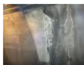
▲トンネル目地部
