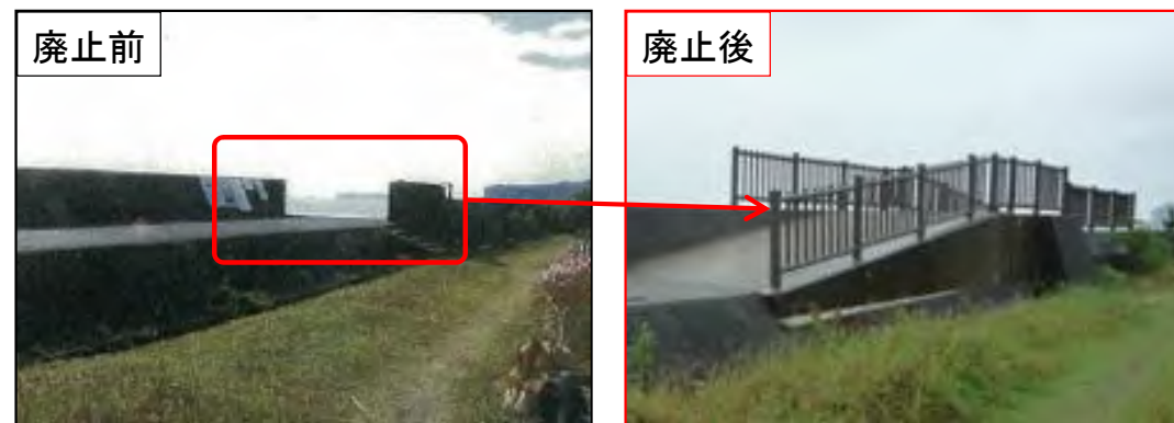
スロープを設置し陸閘を廃止
