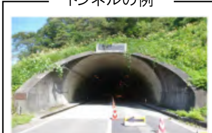
トンネルの例
