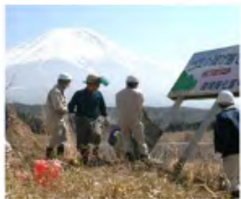
道路空間の修景
