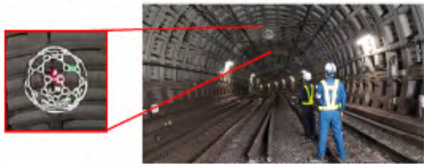
ドローンを活用したトンネル検査（イメージ）
