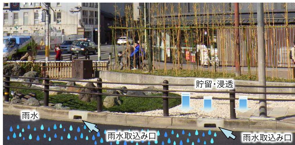
地上に降った雨水を、下水道に直接放流することなく一時的に貯留し、ゆっくり地中に浸透させる構造を持った植栽空間であり、修景・緑化に加え、雨水流出抑制、水質浄化、ヒートアイランド現象の緩和などの効果が期待される
