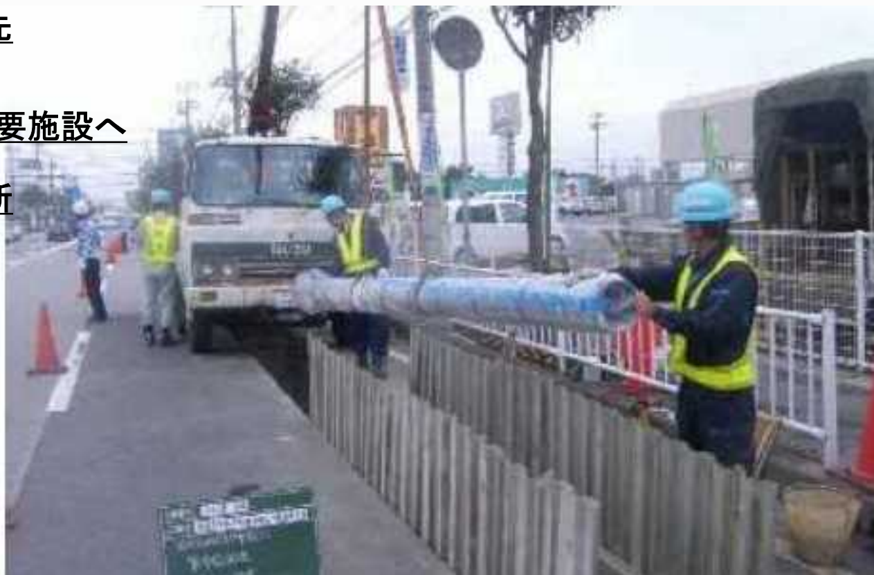
鋳鉄管更新工事の状況
