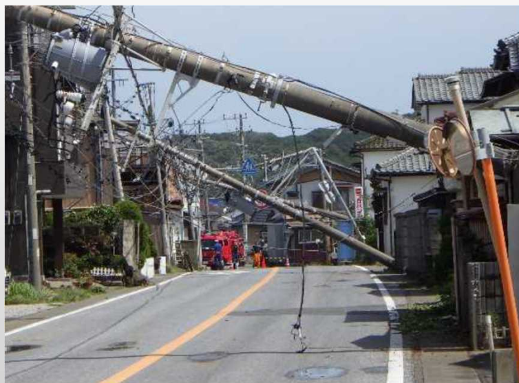
電柱倒壊状況（館山市）
