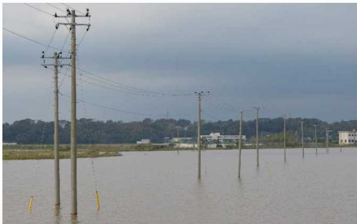
大雨による浸水状況（佐倉市鹿島川大橋付近）
