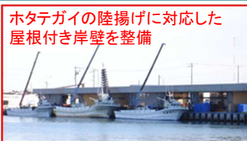
屋根付き岸壁の整備期間: H19~H22
