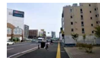
整備後(撮影 令和元年度)
