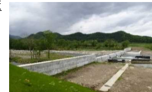
十勝川水系戸蔭別川第2号砂防堰堤 (帯広市)
