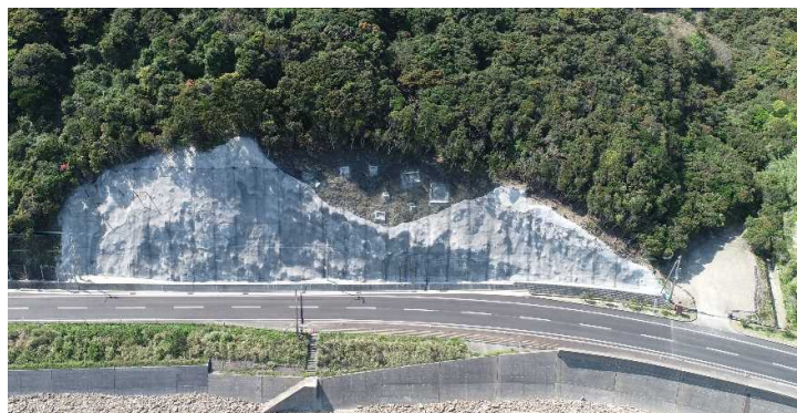
法面吹付工、落石防止網工
