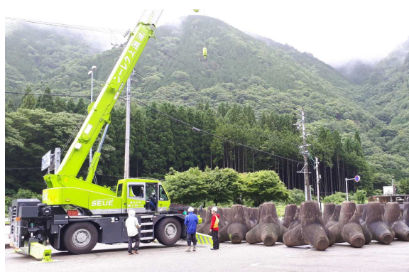
道路崩壊に対応するための 資機材の保管場所
