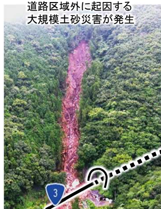
令和2年7月豪雨 (14日間の通行止め)
