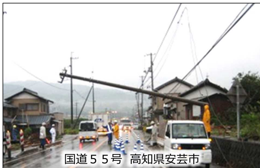
【沿道民地の電柱が倒壊し道路を閉塞した例】
