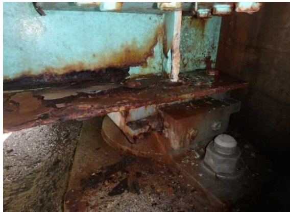
地方自治体管理 主桁腐食
