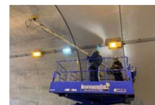
レーザーを利用したトンネル覆工の損傷把握
