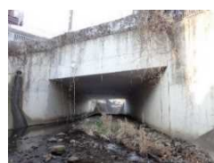
▲水路ボックス
