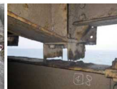
▲シールド主梁端部破断
