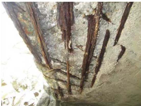
国管理 床版鉄筋露出
