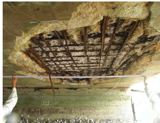
地方自治体管理 床版鉄筋露出
