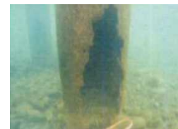
▲橋脚水中部の断面欠損
