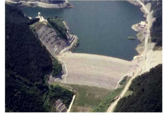
有間ダム(埼玉県) S60事業完了
