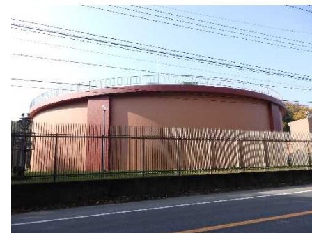
中里中継ポンプ場(調整池)
