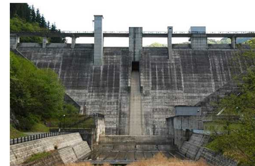
合角ダム(埼玉県) H14事業完了
