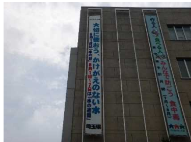
節水啓発懸垂幕を設置 (R1.8) 埼玉県
