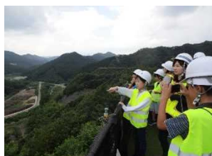
南摩ダムサイト見学
