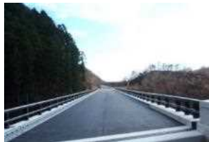
付替県道工事
