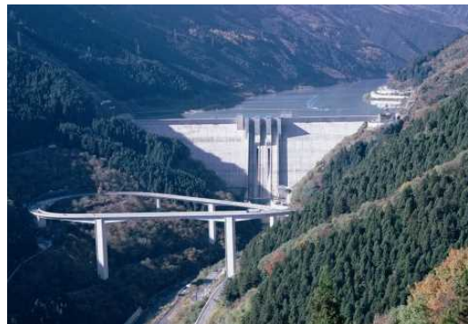
滝沢ダム(水資源機構) H22事業完了
