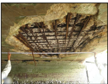
内部の鉄筋が露出した橋梁 陥没した港湾施設のエプロン部分
