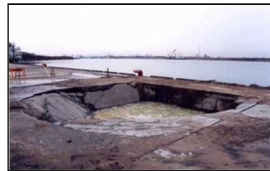
内部の鉄筋が露出した橋梁 陥没した港湾施設のエプロン部分
