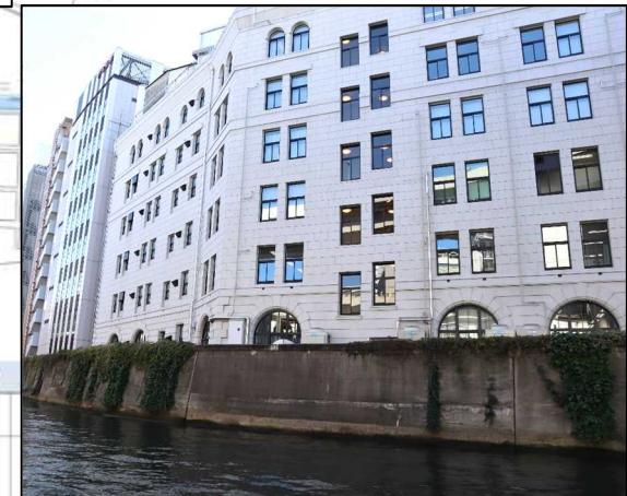
川から見た日証館
