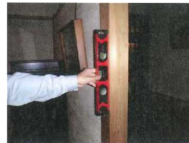
水平器による柱の傾きの計測
