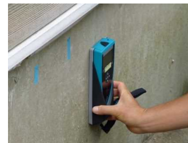
基礎配筋の調査
