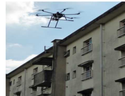
ドローン等を用いた外壁部の瑕疵判定の実施（イメージ）
