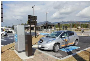
SAのEV充電の様子(多賀SA)
