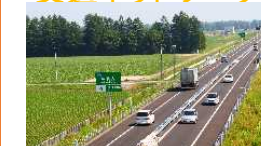
帯広広尾自動車道
