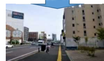
整備後(撮影 令和元年度)
