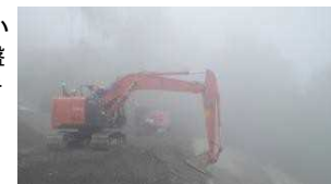
濃霧条件下での施工状況
