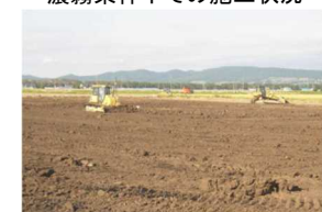
整地工の状況
