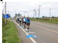
路面への通行位置明示
