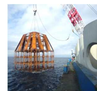
鋼製魚礁を中心にコンクリート魚礁を設置
