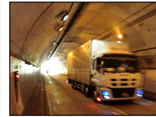
写真5 幅員狭小トンネル
