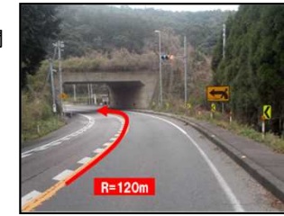
写真4 線形不良箇所
