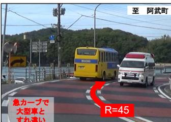
写真5 平面線形不良箇所
