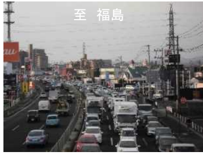
写真1 国道4号の混雑状況
