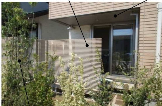
日射遮蔽（中高木）※植栽直後 湿球温度付近まで低下する冷却面（保水性平板）
