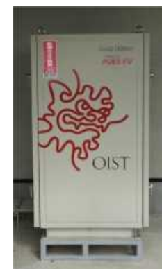
定置型蓄電池:通常の約半分の大きさで自立可能
