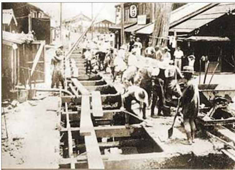
(昭和8年 船町幹線工事の様子)
