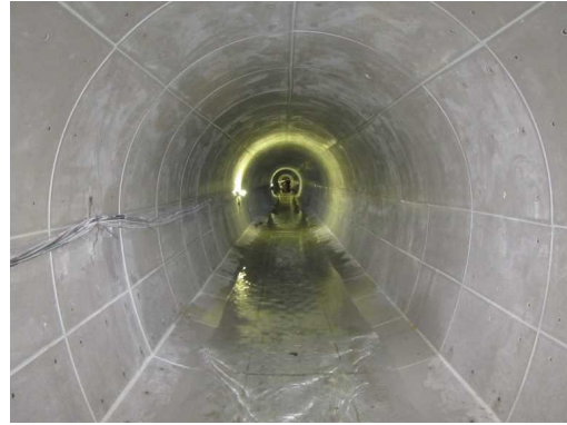
図 51 群馬用水緊急改築事業（左：地下水の侵入、右：内巻き補強施工完了）
