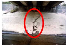
コンクリートの損傷
