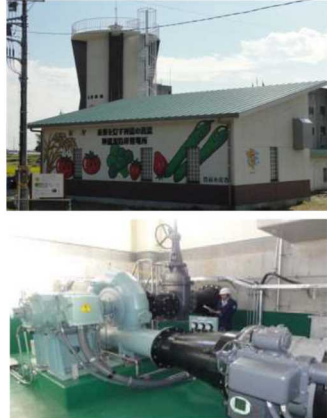
小水力発電施設
