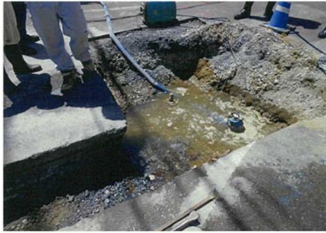
図 72 漏水状況（千葉県工業用水道）
