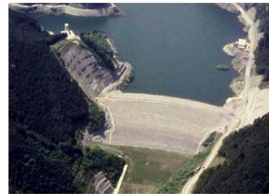
有間ダム(埼玉県) S60事業完了
