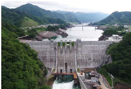
ハツ場ダム(国土交通省) R元事業完了
