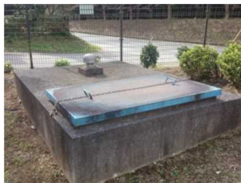
神崎町水道 古原浄水場水源1号井
