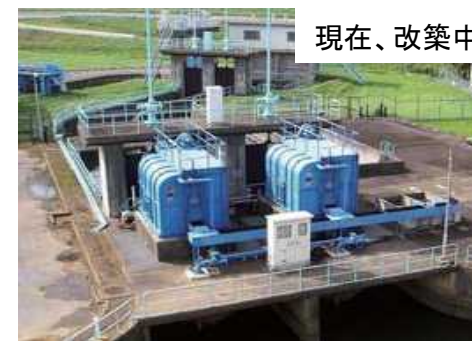
成田用水施設(水資源機構) S55事業完了
