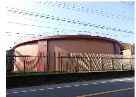
中里中継ポンプ場(調整池)
