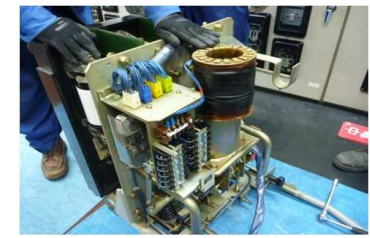
電気設備の焼損状況
