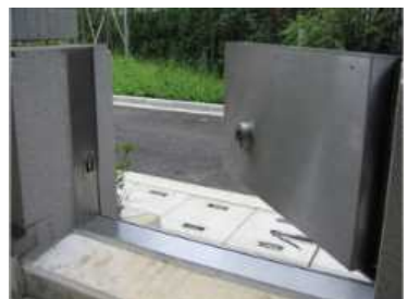
<整備例> 防水扉(金町浄水場)
