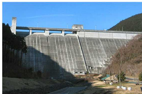
松田川ダム(栃木県) H7事業完了
