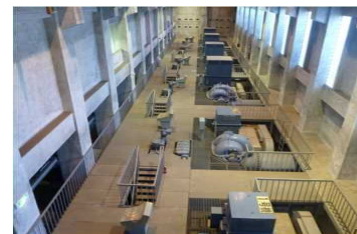
老朽化した横芝揚水機場
