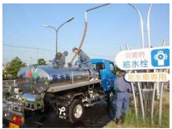
出典: 埼玉県提供 給水車の配備
