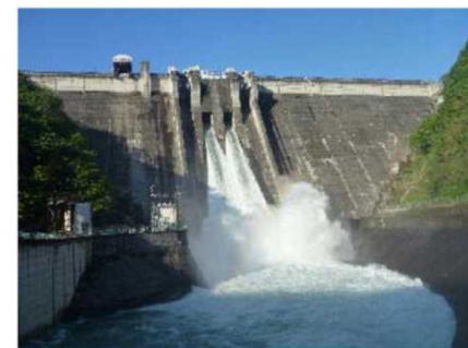
水質事故時における下久保ダムから下流河川への放流増の様子(H24.5.17)
