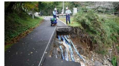
栃木県栃木市の被災状況調査(R1.10.18)
