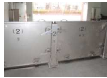
止水板(葛西給水所)
