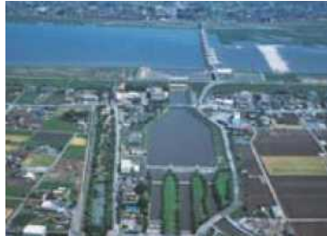
末田須賀堰(埼玉合口二期施設)
