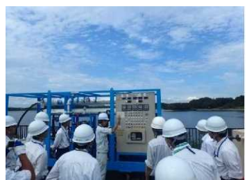
可搬式浄水装置の操作訓練 出典: 可搬式浄水装置((独)水資源機構)
