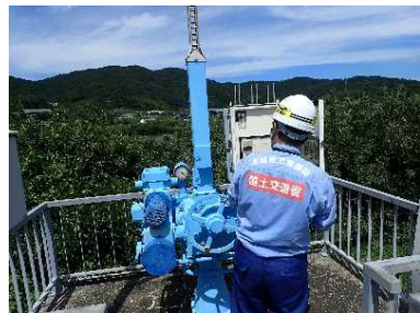
施設毎に機側操作盤により操作
