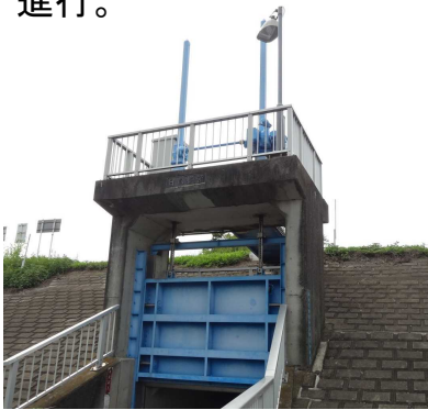
施設毎に機側操作盤により操作
